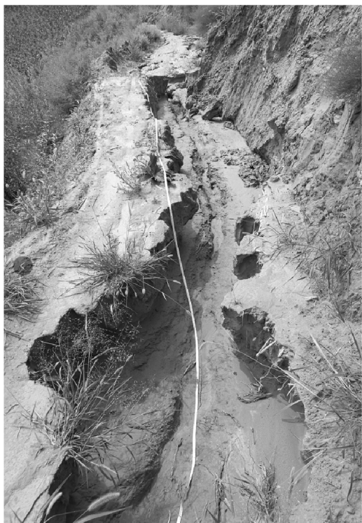
图 2 强降雨引起的切沟侵蚀
